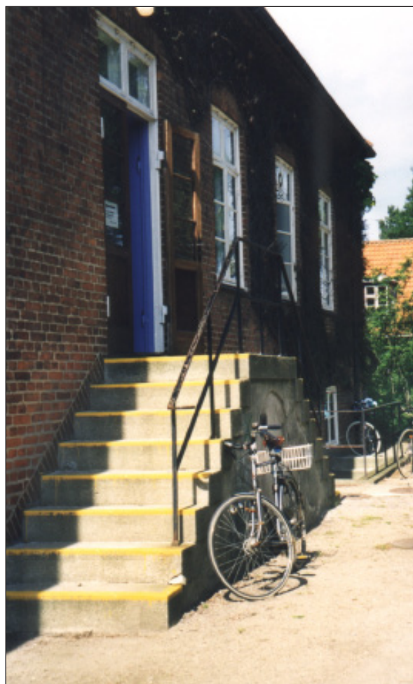
Malet kant ved trappe
